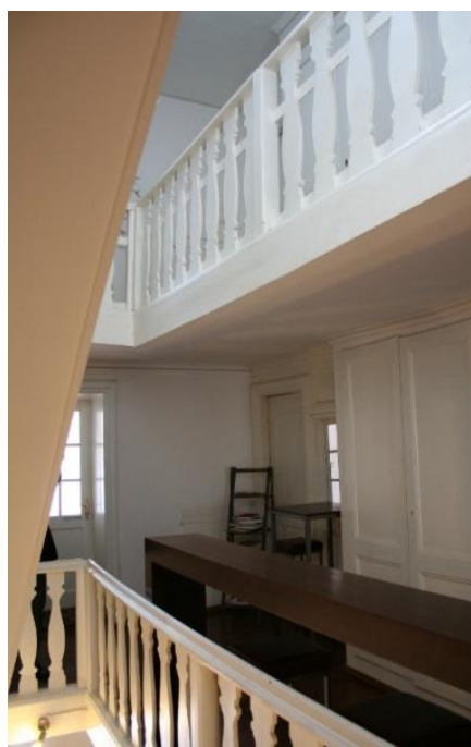
Figure 1 : Rampes et balustres d'origine.
