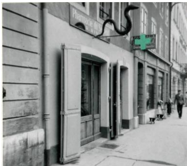
Figure 32 : Photographie tirée du dossier de demande d'autorisation pour une croix verte sur la façade, 1963.
