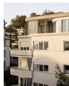
Curélisation d'un immeuble de logements à Pully, FAZ Architectes
