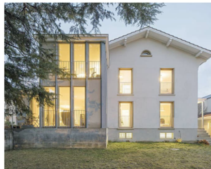
Extension d'une maison à Renens Dreier Frenzel architecture
