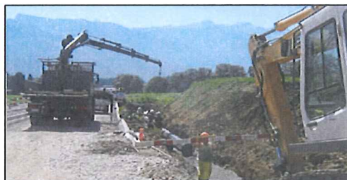
Pose de conduite 500 mm
