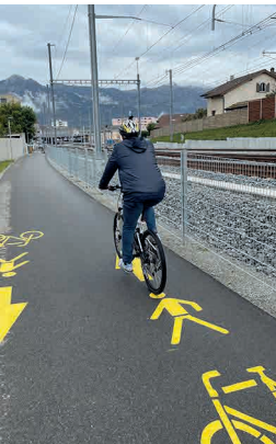
La voie verte entre la gare et Planchy-Nord, sécurité et confort maximaux pour les cyclistes et les piétons.
