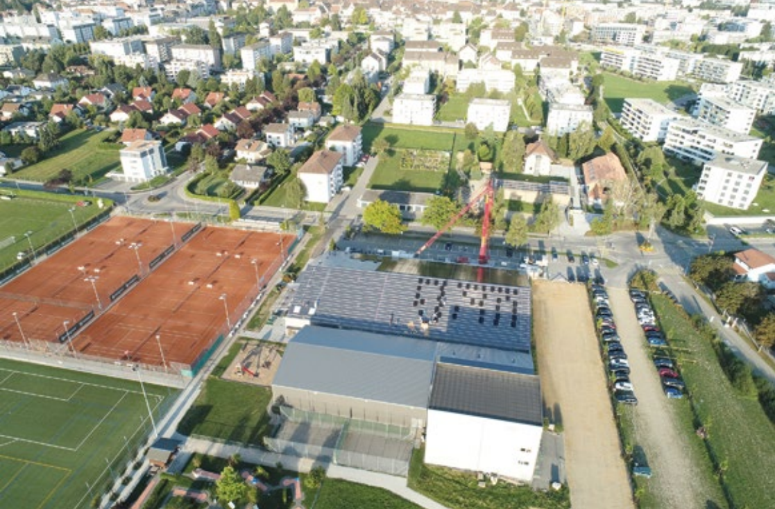
Le Centre de tennis de Bulle et ses 1135 modules solaires en construction cet automne. ©15Prod
