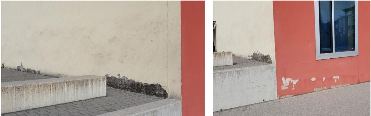
Les travaux proposés consistent à enlever le crépi détérioré, à appliquer un bitume sur les parties enterrées (jusqu'à - 20 cm environ), à poser un revêtement en carrelage de façon à créer un socle et à procéder à la réfection de la peinture de la façade. De plus, les fissures et les joints de dilatation seront assainis dans le même temps.
