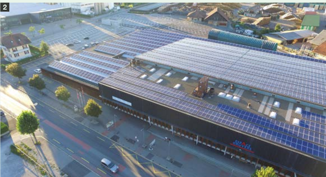
Espace Gruyère et ses 3800 m 2 de panneaux solaires photovoltaïques (©Espace Gruyère)
